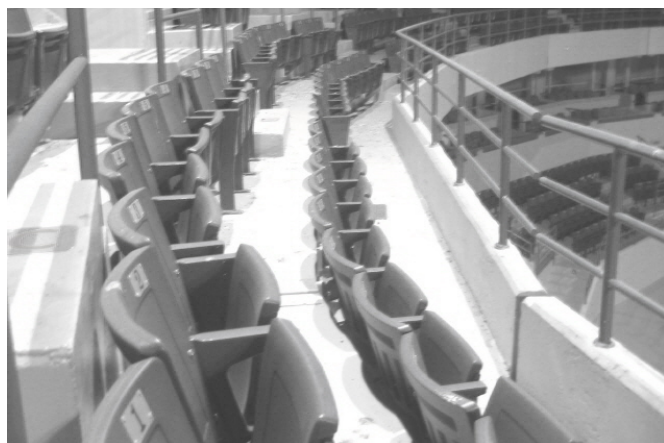
Slika 3 - Izgled tribina sa geometrijom koja utiče na vrednost koeficijenta raspršavanja pri refleksiji zvuka.
