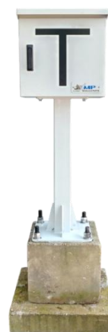
Sl. 3 Telefonski orman i noseći stub
