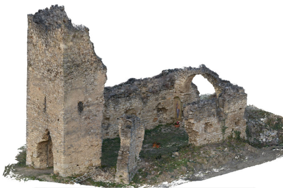
Sl. 1. Oblak tačaka objekta crkve manastira Savinac, u softveru AutoCAD.
